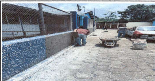
Foto 5: Repello de muro perimetral
