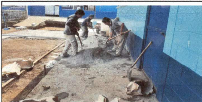
Foto1: Reparación de patio
