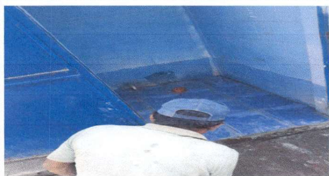
Foto3: Cambio de fosas sépticas por sanitarios lavables
